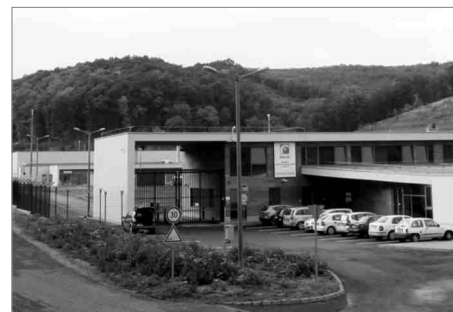
A bataapáti felszíni létesítmények kifogástalanul üzemelnek, a felszín alatt pedig 2011-től fogadják majd a hordókat
