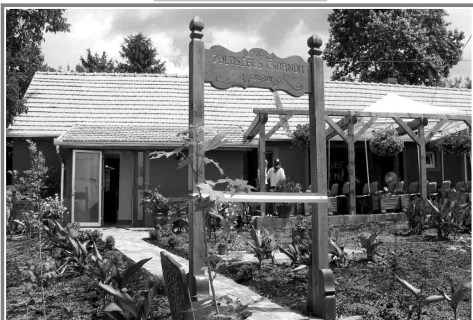
A Cserdiben átadott zöldséges csarnok műves bejárata július óta várja a vásárlókat
